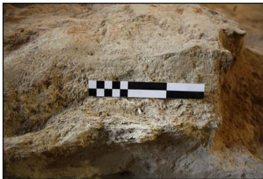
Fotografia 49. Detall regruix de calç parets interiors UE178.
