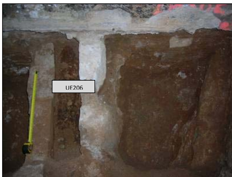
Fotografia 16. Claveguera s. XIX UE206 localitzada a l'encepat 6.
